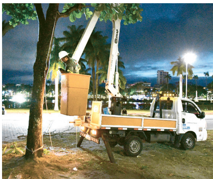
A instalação da iluminação natalina segue em ritmo acelerado
